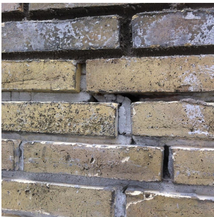
Ved huller i fugemørtlen skal mørtel fjernes så fugen kan fyldes fuldstændig med mørtel. Løs mørtel skal fjernes og fugerne fuges med mørtel
